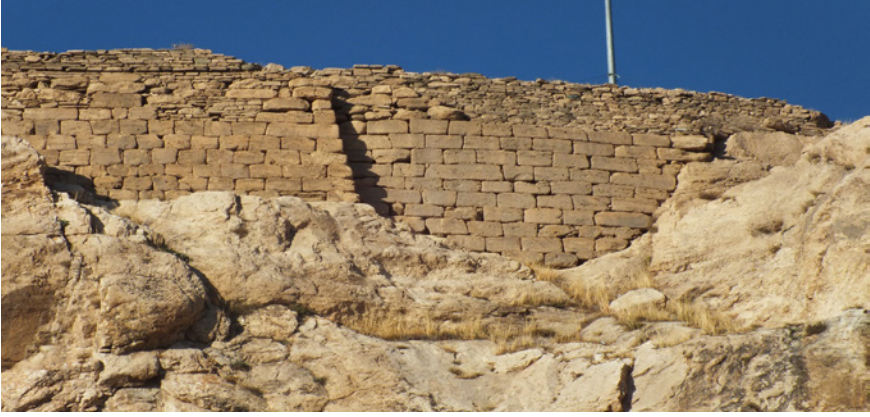
Fig.11- Van Kalesi Yukarı Sitadel güney sur duvarlarında kullanılan traverten bloklar.
