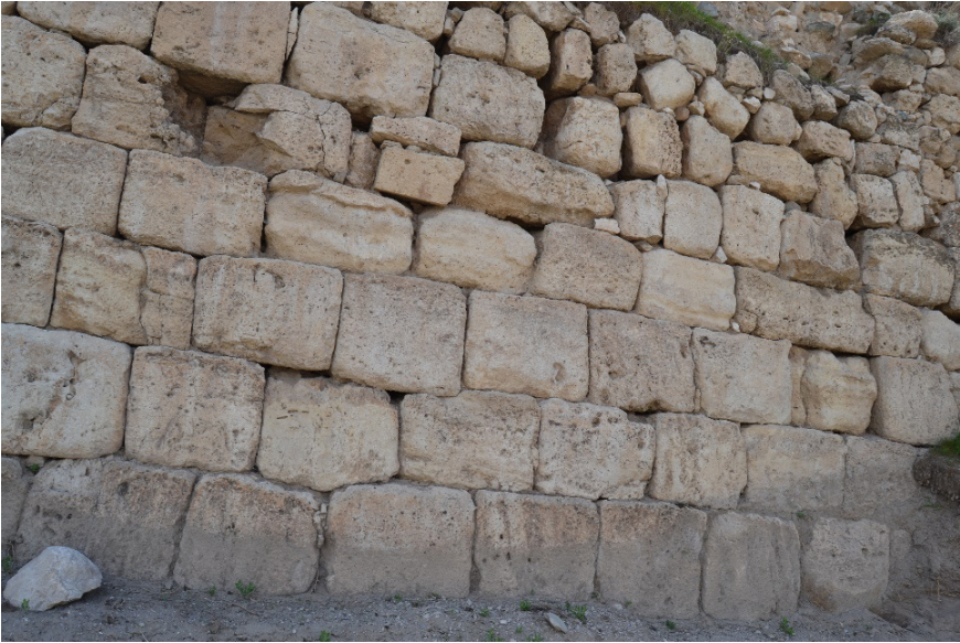
Fig.12- Van Kalesi Yukarı Sitadel kuzey sur duvarlarında kullanılan traverten bloklar.
