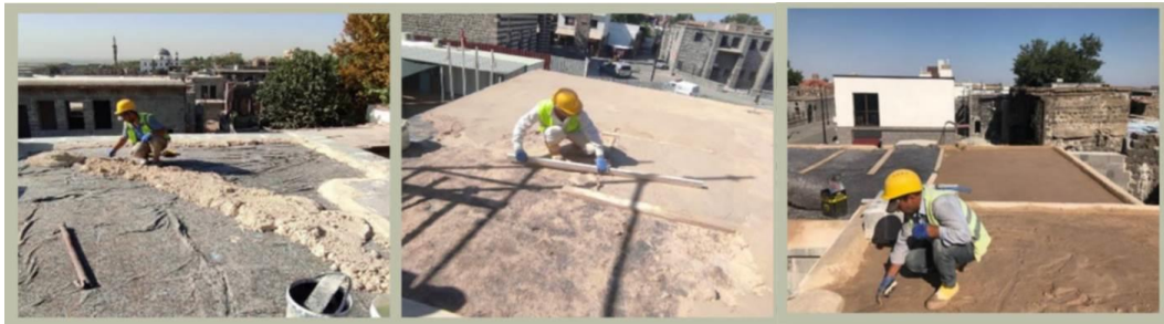
Şekil 32. Dam Harcının Serilmesi.
