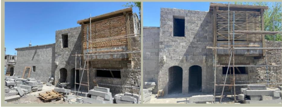
Şekil 29. Bağdadi Çıtaların Yerleştirilmesi.
