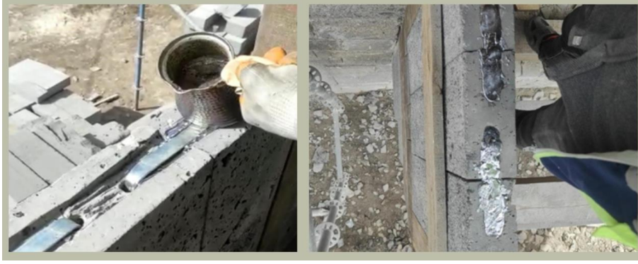
Şekil 28. Kurşun ile Taşların Kenetleme İşlemi.
