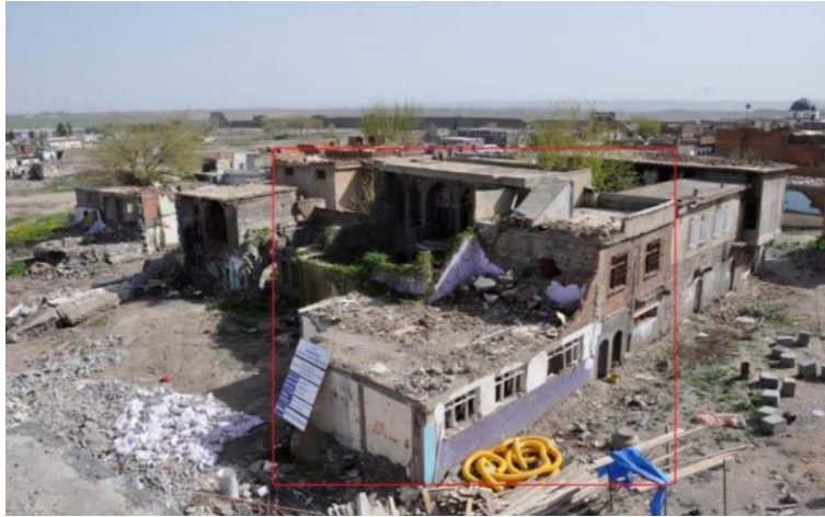
Şekil 1. Uygulama Öncesi Yapının Genel Görünümü (Diyarbakır Rölöve ve Anıtlar Müdürlüğü Arşivi)
