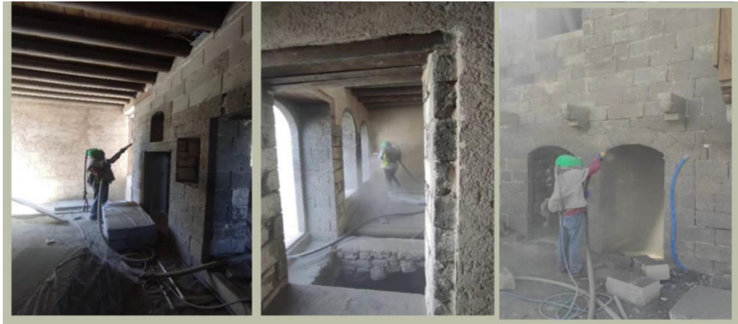
Şekil 25. Konutta Yapılan Mikro Kumlama İşlemleri.
