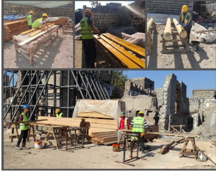
Şekil 21. Kullanım Öncesi Ahşap Malzemelere Yapılan Bazı İşlemler.
