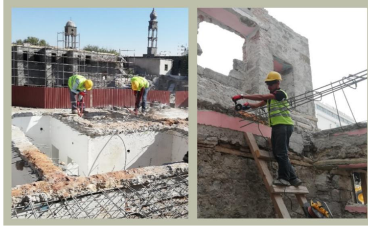
Şekil 23. Demir Donatının Kesimi İçin Kullanılan Demir Makas ve Spiral ile Kesim Yöntemleri.
