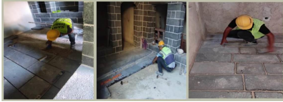
Şekil 37. İç Mekânlarda, Eyvanda ve Avluda Yapılan Taş Döşeme ve Derz Uygulamaları.
