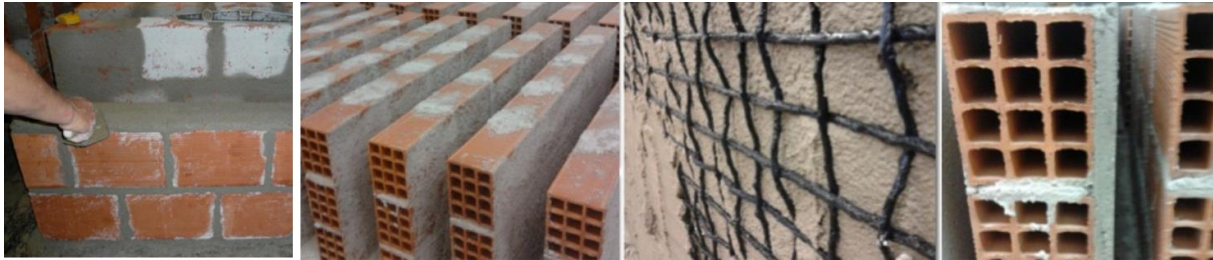
Şekil 14. Deneysel için hazırlanan duvarların yapımı ve TRM filesi uygulaması [104]. (Construction of walls prepared for the experiment and application of TRM mesh [104].)
