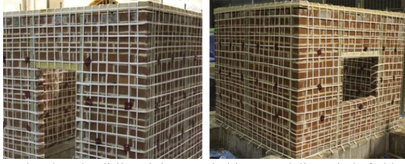
Şekil 10. FRP + PP-bant güçlendirilmesinin prototip bir ev modeli üzerinde farklı görünüşleri [82]. (Different views of FRP + PP-band retrofitting on a prototype house model [82].)
