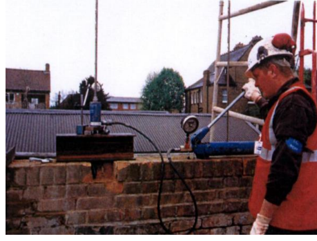
Şekil 8. Ardgerme tekniğinin uygulanması [74]. (Implementation of the post-tensioning technique [74].)
