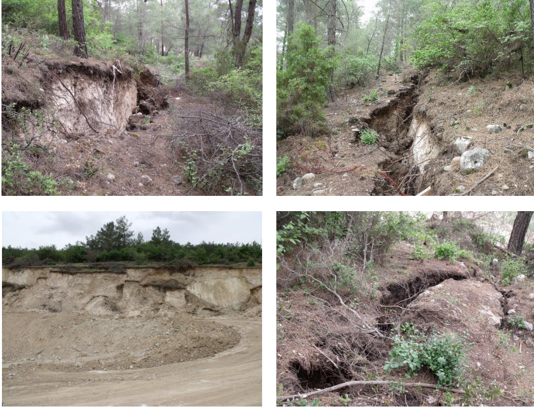
Şekil 2. Sahada görülen gerilim çatlakları ile kısmi kaymaların gözlemlendiği ve muhtemel duraysızlıkların oluşması beklenen şevler
