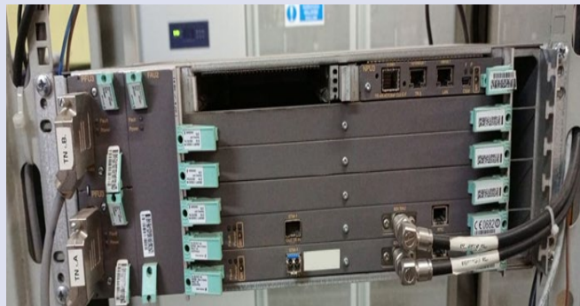
Şekil 6. Karayaprak tepe kullanılan radyo iç ünite Figure 6. Radio indoor unit used in Karayaprak hill
