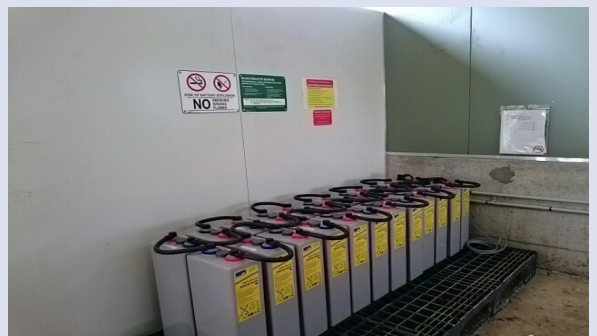
Şekil 4. Karayaprak tepe kullanılan jel aküler Figure 4. Gel batteries used in Karayaprak hill
