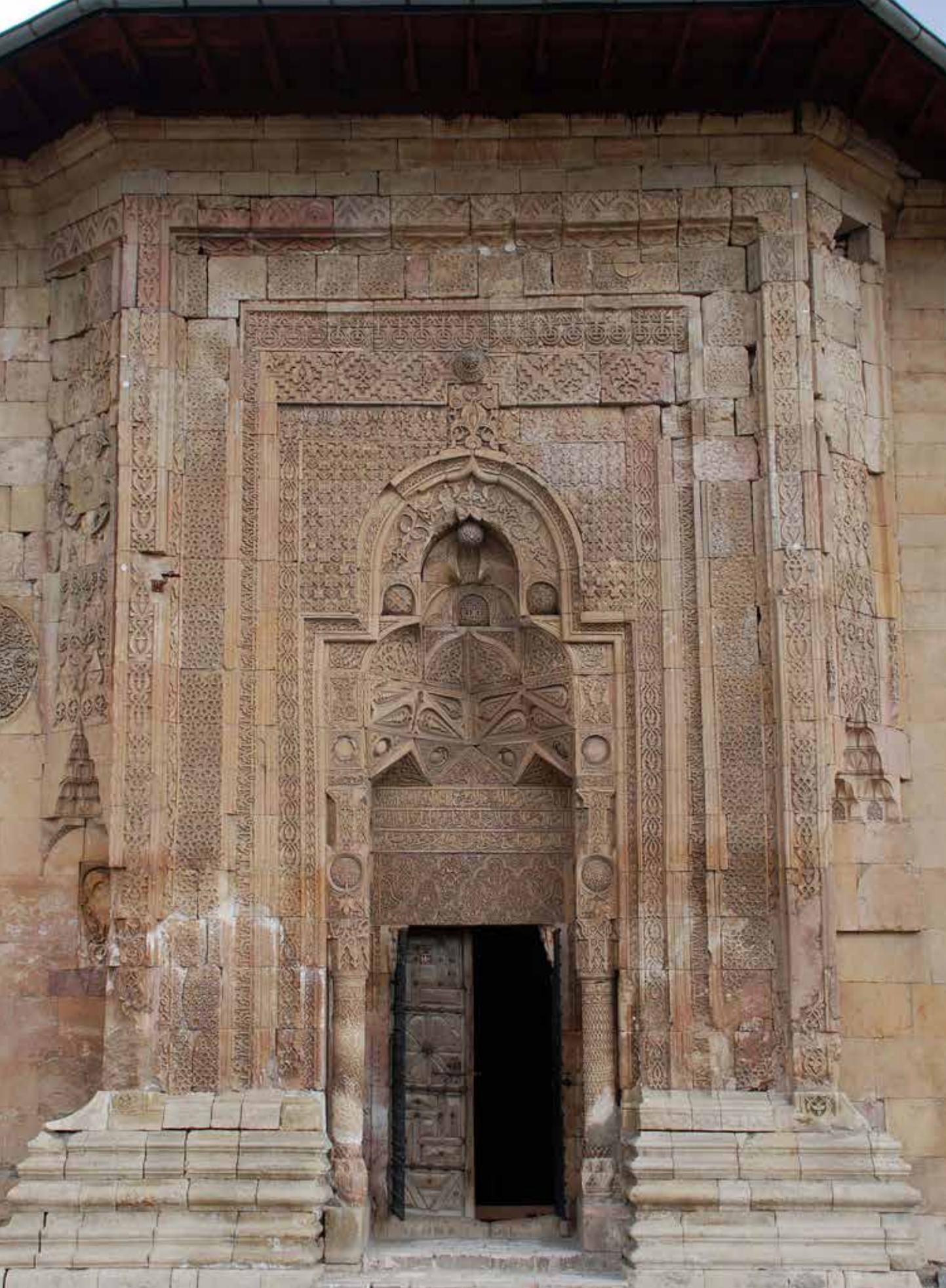
Görsel 3-6: Divriği Ulu Camii ve Darüşşifası taç kapıları Cennet kapısı kuzey, Batı kapısı batı, Darüşşifası kapısı batı, Şah kapısı doğu yönünde bulunmaktadır. (Kaynak https://www.kulturportali.gov.tr/medya/fotograf/arama/divri%C4%9Fi ).
