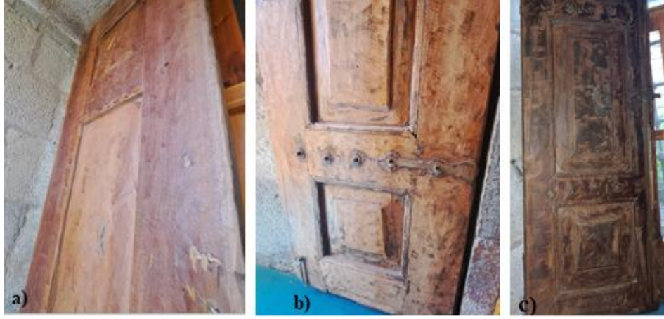
Şekil 2. Murat Paşa Camii pencere iç kepenklerinin; a) Dış yüzeyi, b) ve c) Restorasyon geçirmiş hali (Kaya 2024)
