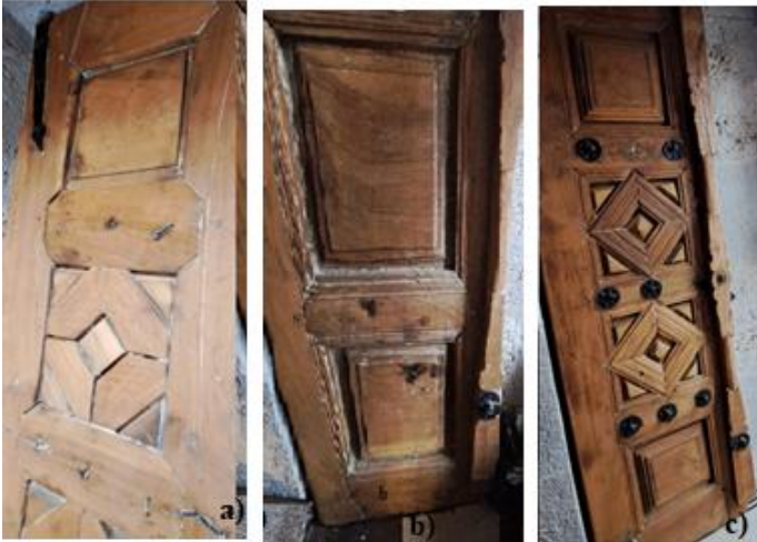
Şekil 4. a) Pencere iç kepenklerinin cami içine bakan yüzeyi, b) Tablarukalı pencere iç kepenği, c) Pencere iç kepenkteki bini çıtası (Kaya 2024)
