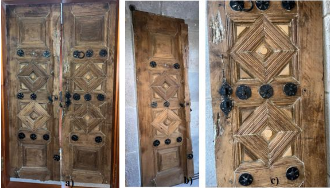
Şekil 3. Gürcü Mehmet Paşa Camii; a) Kepenklerin kapatılmış hali, b) Bini çitallı kepenk sol kanadı, c) Süsleme amaçlı rozet ve farklı geometrik şekilli kepenk kanadı (Kaya 2024)
