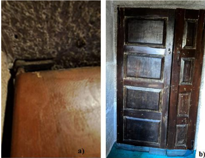
Şekil 7. Bakırcı Camii; a) Menteşe kanat bağlantısı, b) Pencere iç kepenginin diğer yüzü (Kaya 2024)
