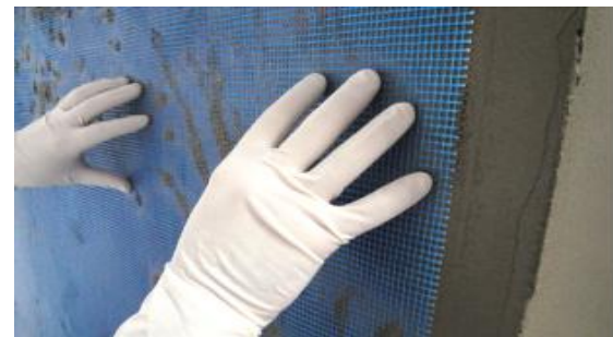
Şekil 32. Donatı filesi olarak leno dokuma uygulaması ( www.artherm.com ., 2012)
