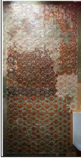
Görsel 11. Bâyezid Camii hünkâr mahfili (Yazar).
