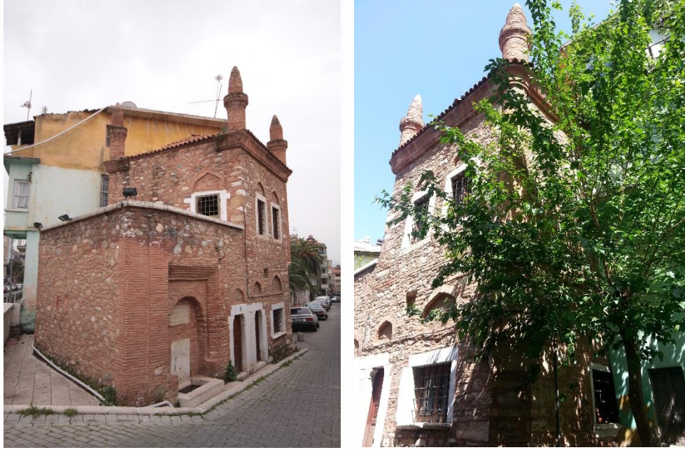
Fotoğraf 9: Kuzeybatı Cephesi (sol), (sağ) Güneybatı Cephesi (Foto: Dere, M.E.)
