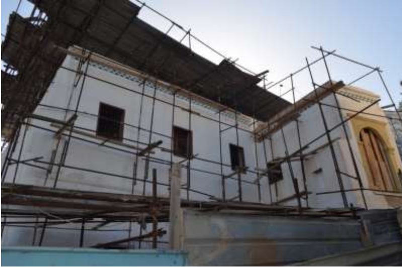
Fotoğraf 10. Kuzeydoğu cephedeki pencerelerden detay.
