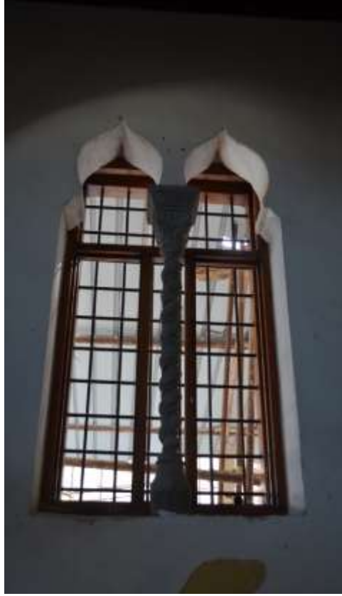
Fotoğraf 25. Harim güneybatı duvarındaki ikiz pencereden detay
