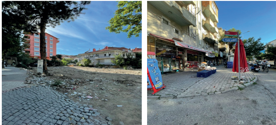
Fotoğraf 4a ve 4b: Bozulan Yol ve Kaldırımların Onarılmaması (Solda) ve Esnaflar Tarafından Kaldırımların İşgal Edilmesi (Sağda)
