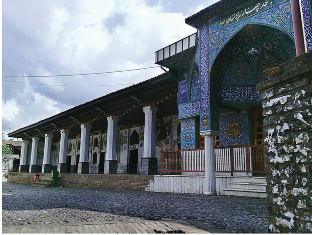
Şekil 1: Lâhîcân Dört Padişah Türbesi. https://fa.org/wiki/بقعه_چهار_پادشاه
