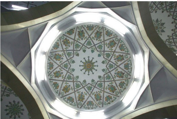
Fotoğraf 9. Ali Şir Nevâyî İstasyonu Kubbe İşlemeleri (Kaynak: https://metrotashkent.narod.ru )
