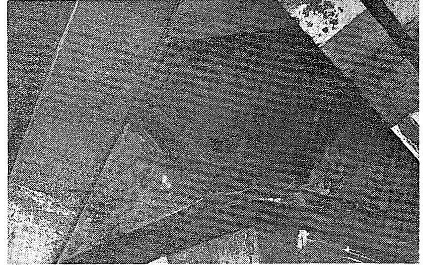
Resim 13. Mehmed Çelebi Türbesi. Üçgen kanadın örtü sistemi.
