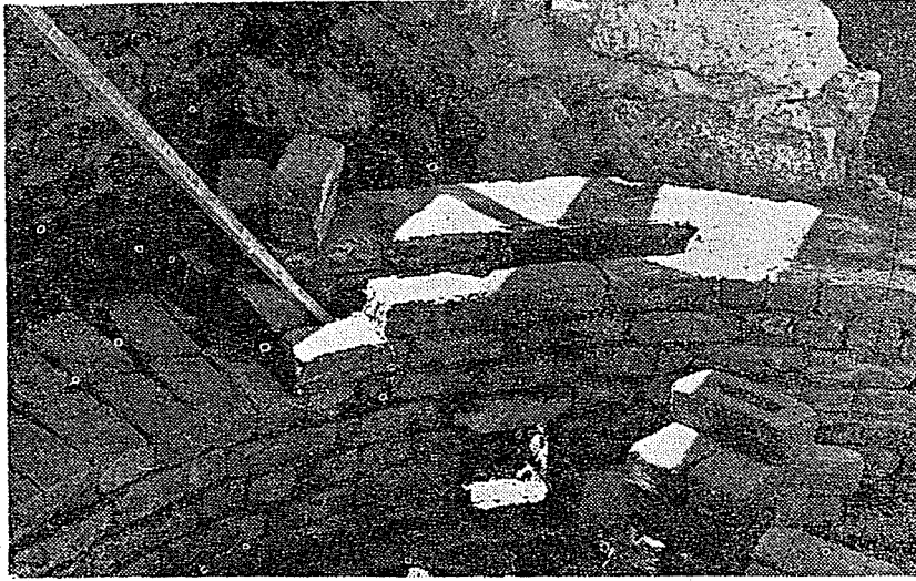
Resim 14. Fişek deliği ve gömlek duvarı. (Yapım halinde)
