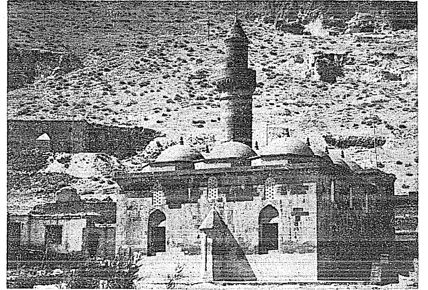
Resim 17. Adilcevaz Zal Paşa Camii.
