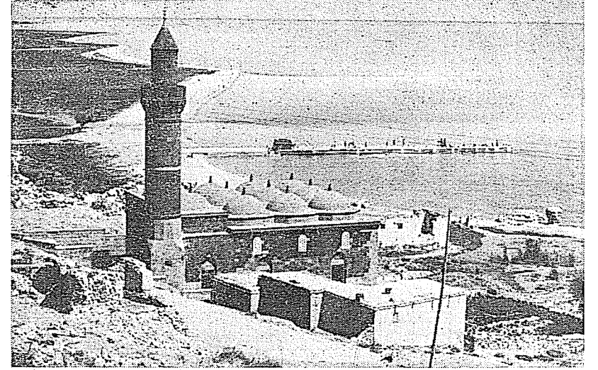
Resim 16. Adilcevaz Zal Paşa Camii.
