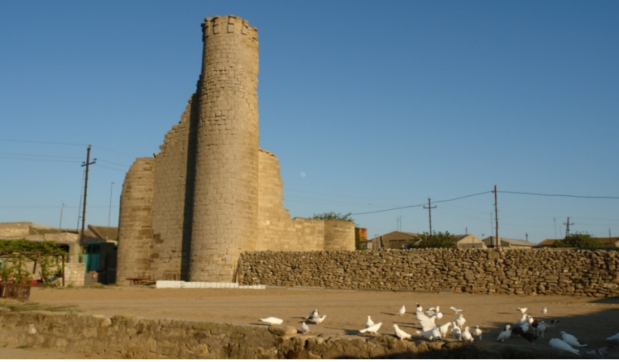
Resim 29: Şağın Kalesi, genel görünüş
