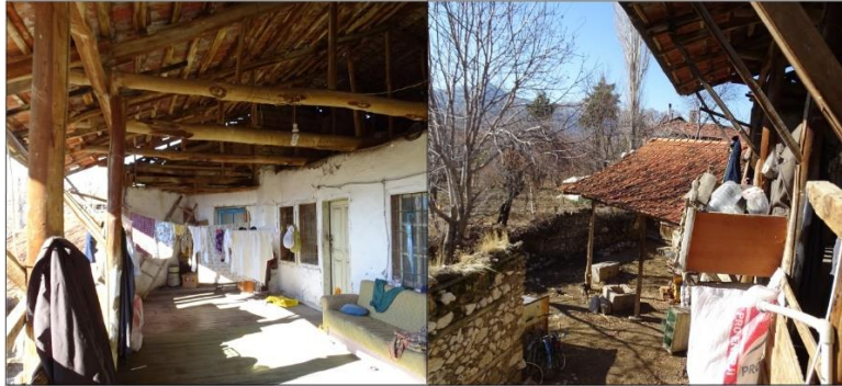
Fotoğraf 5: Hanay( solda ) ve saçak altında çıkmalı bir şekilde yapılan bulaşıklık (sağda).
