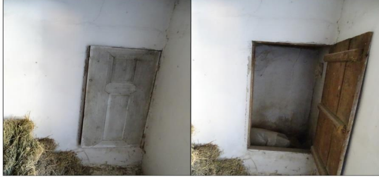
Fotoğraf 8: Oda duvarına gömülme suretiyle yapılmış günümüz duş kabinlerinden daha çok mahremiyet duygusu taşıyan gusülhane örneği
