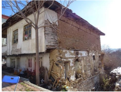
Fotoğraf 4: Temel ve zemin kat taş yığma 1. Kat yan ve arka cephelerinin kerpiç ön cephenin ise bağdadi tarzda yapıldığı mesken örneği.
