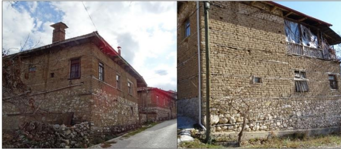
Fotoğraf 3: Temeli (sağda) ve birinci katı (solda) taş yığma tekniğiyle yapılmış olan mesken örnekleri
