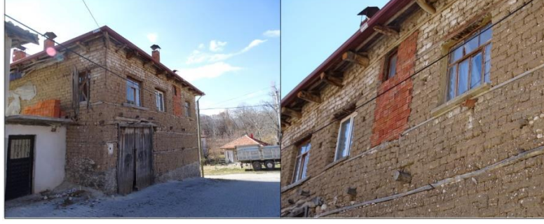
Fotoğraf 14: Modern yapı malzemelerinin geleneksel meskenlerde onarım için kullanımına örnek.
