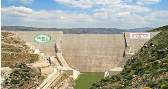
Fig. 5. Cine RCC Dam (DSI 2015)
