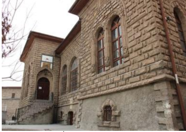
Şekil 11. Aksaray İl Halk Kütüphanesi'nin Doğu Cephesi.
