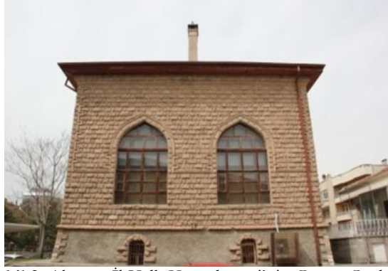
Şekil 9. Aksaray İl Halk Kütüphanesi'nin Güney Cephesi.
