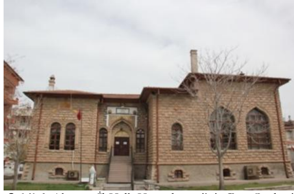
Şekil 6. Aksaray İl Halk Kütüphanesi'nin Batı Cephesi.
