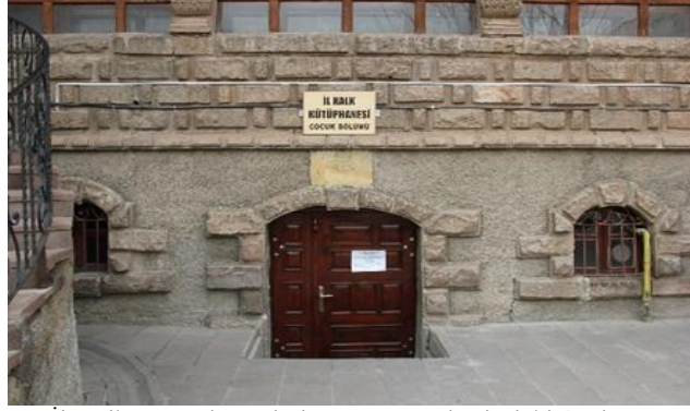
Şekil 13. Aksaray İl Halk Kütüphanesi'nin Doğu Cephesindeki Bodrum Kata Giriş Kapısı.
