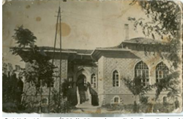
Şekil 2. Aksaray İl Halk Kütüphanesi'nin Batı Cephesi 6 .
