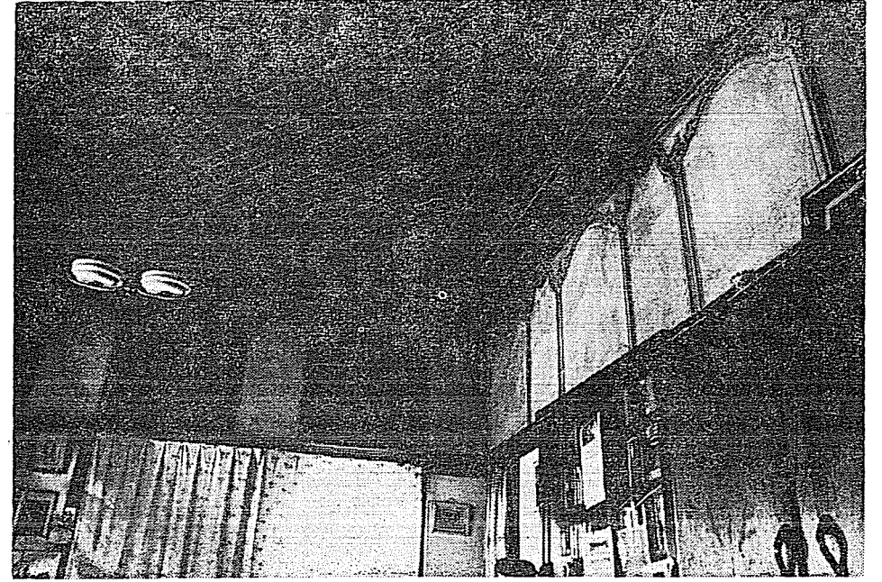
Resim 17. Manzaralı odanın tavanı, kapatılmış üst pencereler ve sağ duvara çizilmiş pencere formları.
