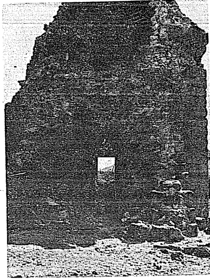
Fotoğraf 8. Giriş bölümünün yıkık hali (V.G.M. arşivinden).
