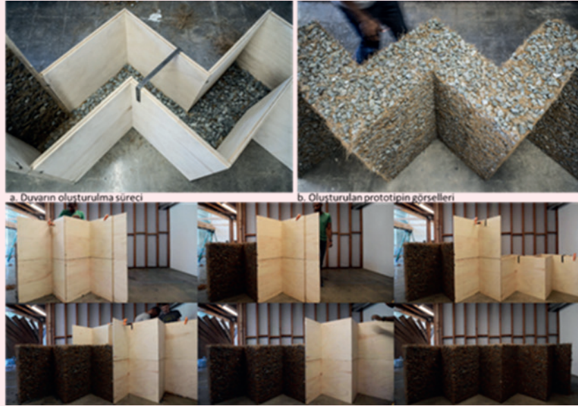
Şekil 21. Slip-Form Rock Jamming Projesi ( a.Duvarın oluşturulma süreci, b. Oluşturulan prototipin görselleri) (URL-18, 2024)
