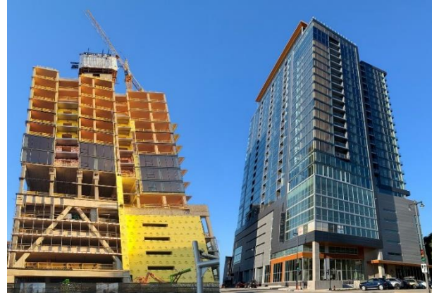
Şekil 12. Ascent Binası İnşaatı [12]
