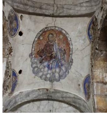
Foto.36 Kıpçular Mahallesi Kilisesi Orta Nef Tonozu "Pantokrator İsa" Ve "İncil Yazarları" Tasviri
