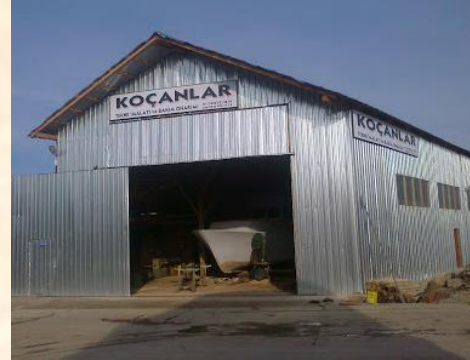
Şekil 7. Fatsa Limanında bulunan bakım-onarım ve çekek yeri.
