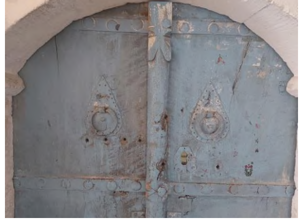
d- Geleneksel Kapı ve Kapı Tokmakları
