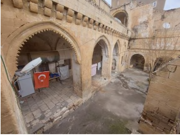
a- Zemin Kat Revak Düzeni
