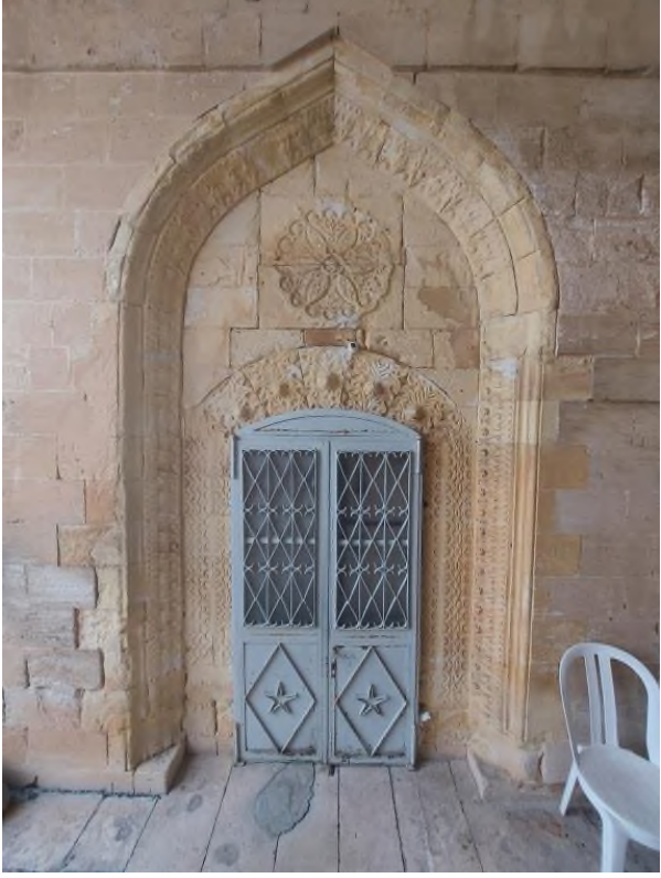
a- Eyvanın Batısındaki Oda Kapısı
