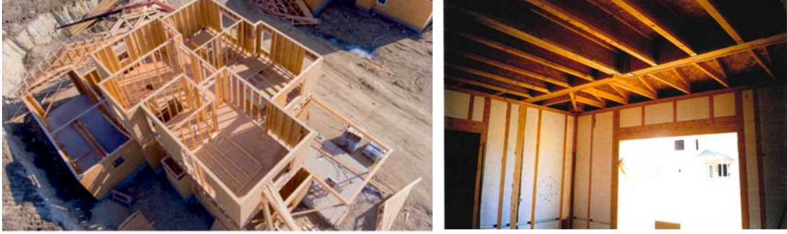
Şekil 8. Platform çerçeve sistemde duvar çerçeveleri ve taşıyıcı I kirişler [21,2]
