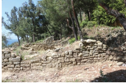
Şekil 61. Z02 Mahal Batı Cephe
