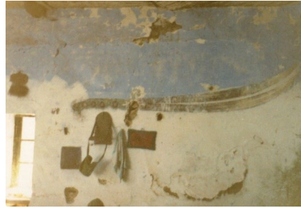
Şekil 47. Türbe Güneybatı Cephinin eski hali (VGM-1989)
