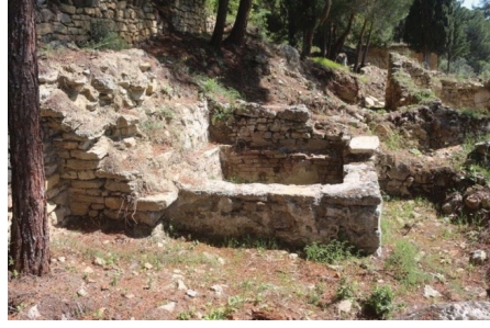
Şekil 83. Z11 Mahal Doğu Cephe ve su deposu
