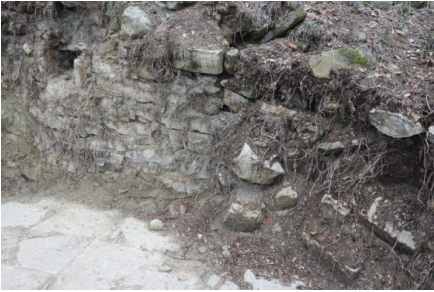
Şekil 68. Z05 Mahal Kuzey Cephe
