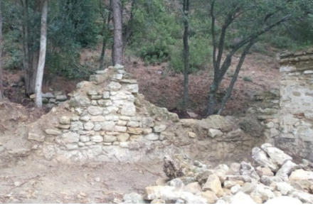
Şekil 60. Z02 Mahal Kuzey Cephe
