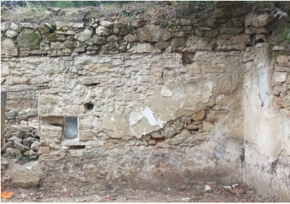
Şekil 46. Türbe Güneybatı Cephe (2023)
