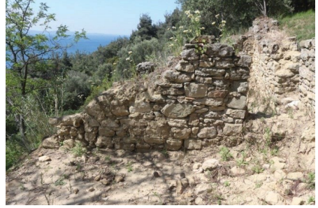
Şekil 89. Z13 Mahal Batı Cephe
