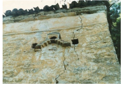
Şekil 42-43. Çatının eski hali – alaturka kiremitli (VGM-1989)
