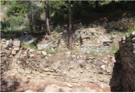
Şekil 78. Z10 Mahal Kuzey Cephe
