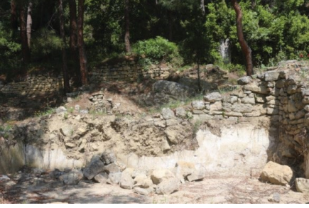
Şekil 72. Z07 Mahal Kuzey Cephe
