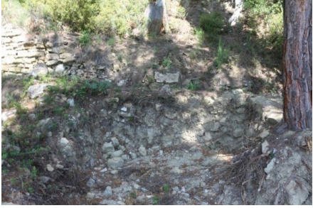
Şekil 62. Z03 Mahal Kuzey Cephe
