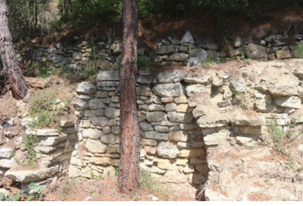
Şekil 82. Z11 Mahal Kuzey Cephe
