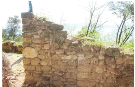
Şekil 71. Z06 Mahal Güney Cephe
