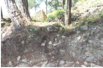
Şekil 63. Z03 Mahal Batı Cephe
