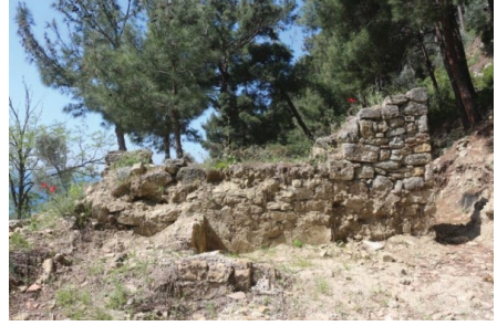
Şekil 67. Z04 Mahal Batı Cephe
