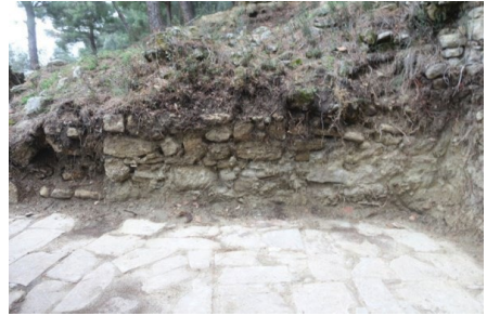
Şekil 69. Z05 Mahal Batı Cephe
