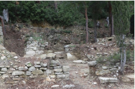
Şekil 64. Z04 Mahal Kuzey Cephe
