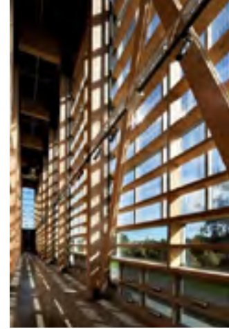
Görsel 14: Kuzey Cephe Görünüşü ve Çepraz Bağlantı Elemanları (URL10)
