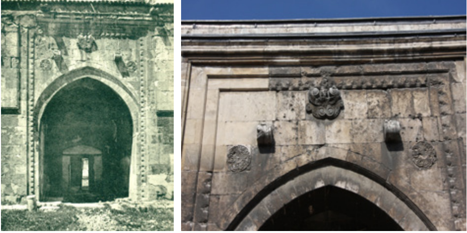
F.21- Sivas Buruciye Medresesi (1271) giriş eyvanının avluya bakan cephesinde yer alan taş konsollar (Soldaki görsel; Gabriel, 1934).
