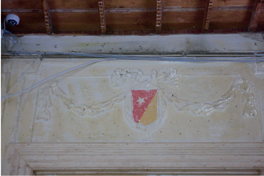
F.29 Collare dell'Annunziata nişanının bina içerisindeki görünümü
