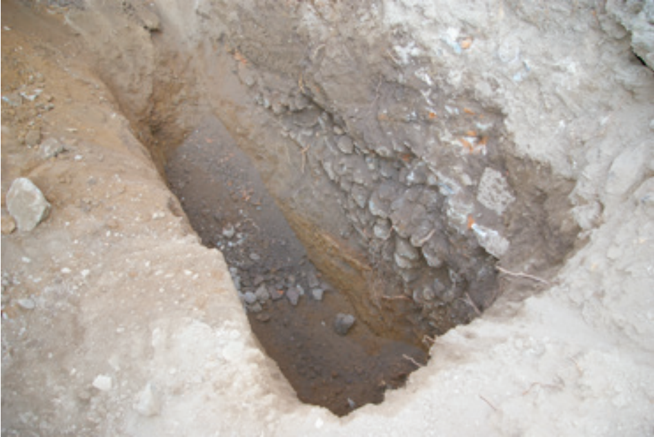
Fotoğraf 8. Zemin kat ile orijinal toprak seviyesi arasına (drenaj için ?) yerleştirilmiş benzer büyüklükteki taşlar.
