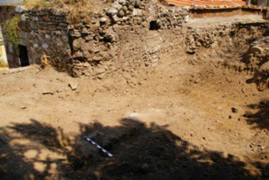
Fotoğraf 6. Arka cephede bulunan batıdaki istinat duvarının ilk sırası.
