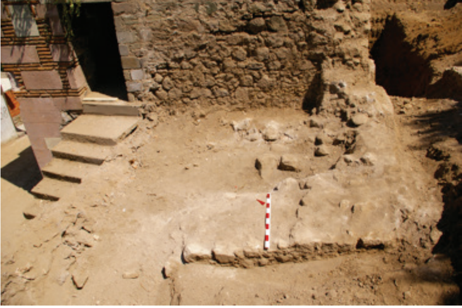
Fotoğraf 9. Önceki yıllarda yapılmış restorasyon esnasında tahrip edilmiş üçüncü galeri tonozu.
