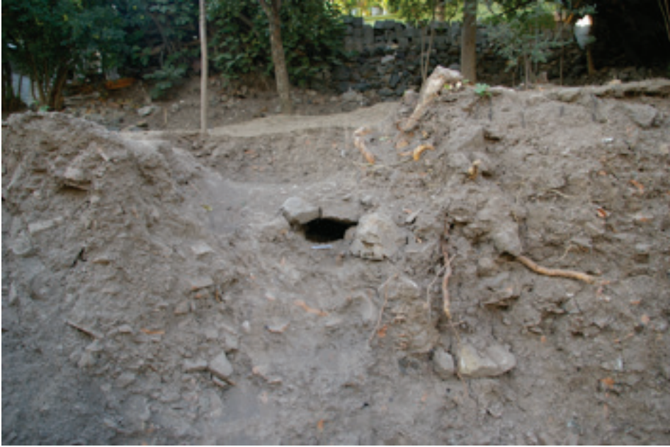
Fotoğraf 27. Binanın arka tarafında günümüz toprak seviyesinin hemen altında bulunmuş Cumhuriyet öncesi kanal.
