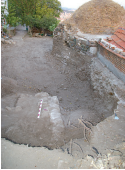
Fotoğraf 5. Arka cephede ortaya çıkan doğudaki istinat duvarının durumu.
