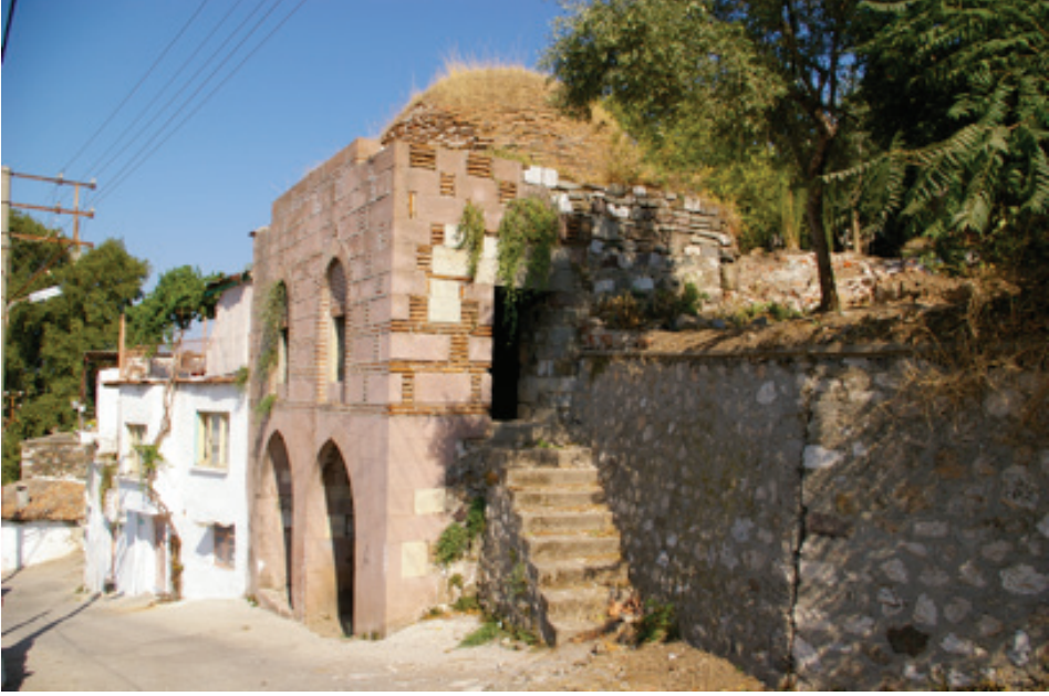
Fotoğraf 1. Darphane olarak adlandırılan binanın kazı öncesi genel durumu (batıdan).
