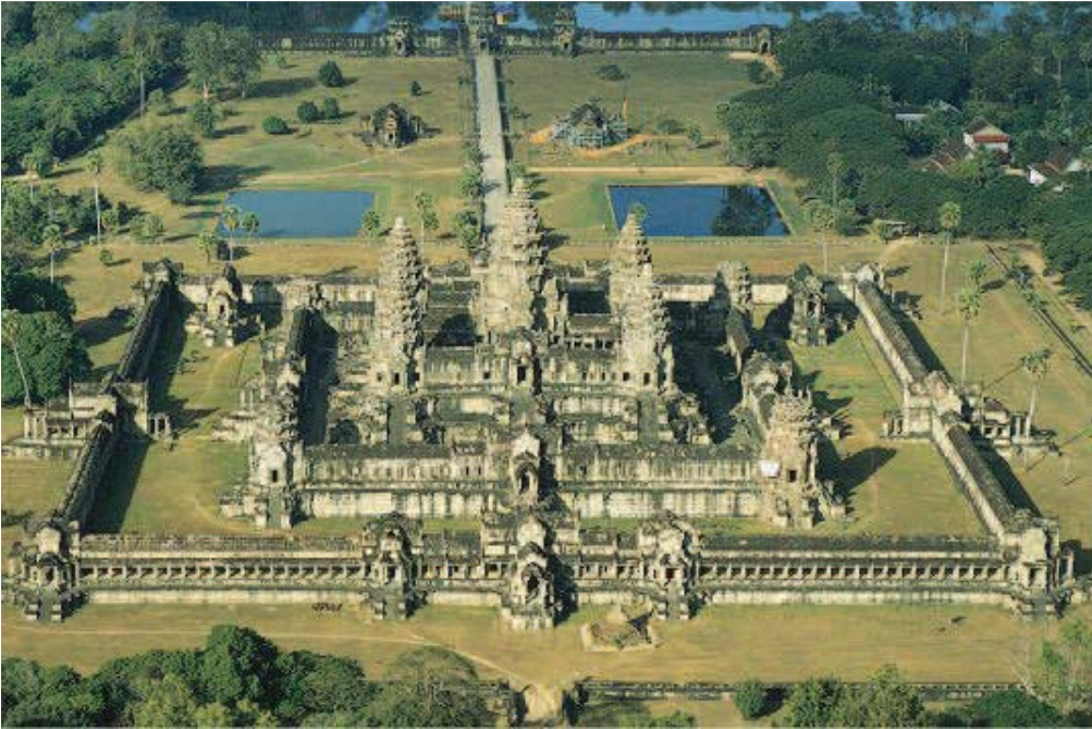
Resim 4: Angkor-Vat Tapınađı'nın havadan görünüşü.
