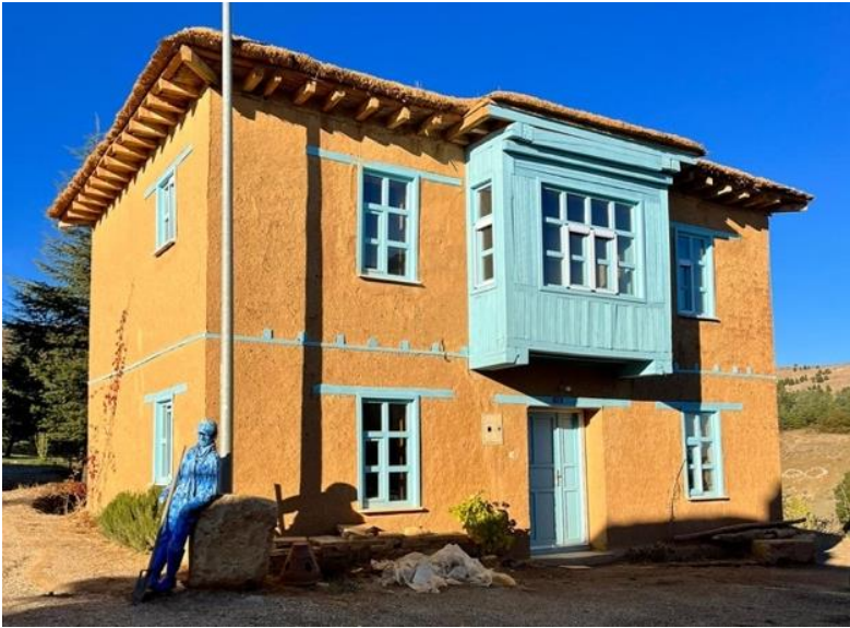
Şekil 5. Sonsuz Şükran Köyündeki kerpiç ev örneği (Uzunay, 2023).
