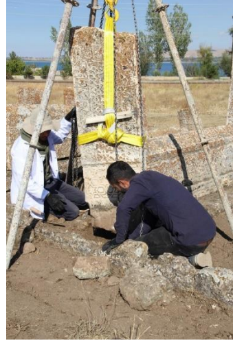
Resim 5 (Zemin Blokaj İşlemi; Müdahale Anı)
