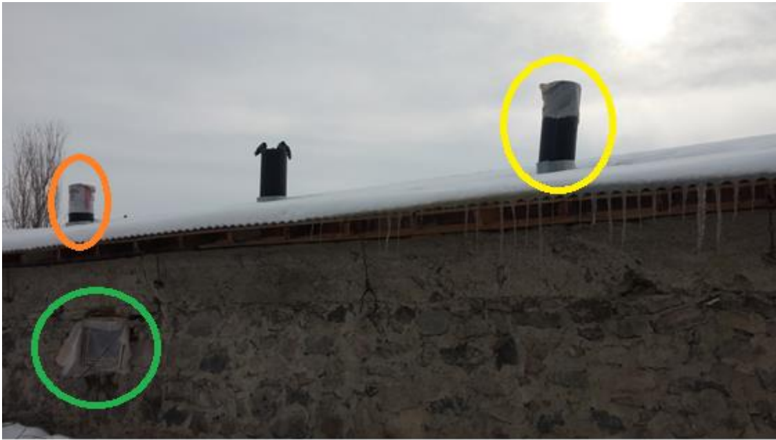
Figure 3. A barn with 2 of its 3 chimneys wrapped and dysfunctional and its window covered with a second layer of plastic sheeting. Şekil 3. Üç bacasından ikisi sarılarak işlevsiz hale getirilmiş ve penceresi ikinci kat plastik örtü ile kapatılmış bir ahır.
