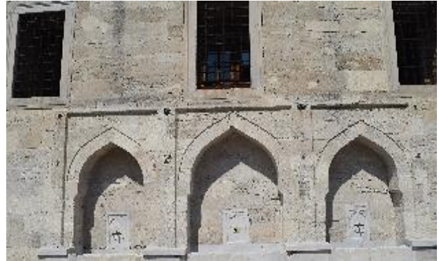
Resim 17: Nurbanu Atik Valide Sultan Külliyesi Çeşmeleri (Kepezkaya, 2024).
