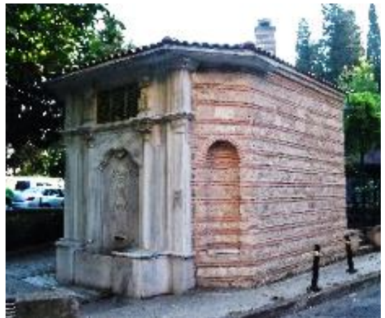
Resim 8: Mihrişah Valide Sultan Çeşmesi H.1206/M.1791 (Kepezkaya, 2024).
