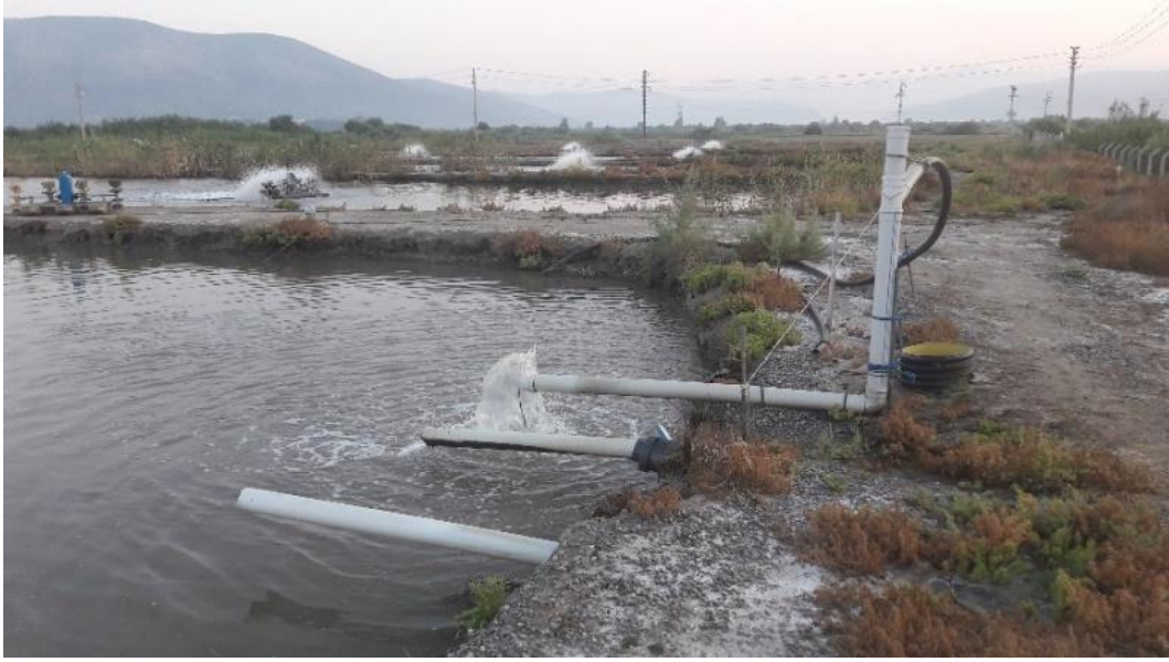
Şekil 3. Suyun çözülmüş oksijen miktarını artıracak yeni havalandırma sistemi
