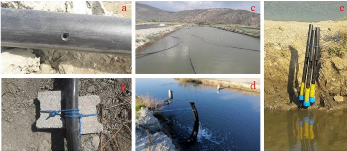
Şekil 2. Taban tahliye sisteminin kurulumu
