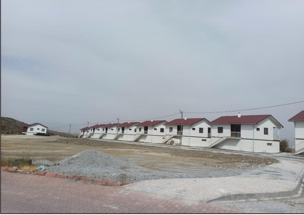
Şekil 7. Malatya Battalgazi’de AFAD’ın talebi üzerine tahsisi yapılan orman alanında inşası tamamlanan afet evleri (Foto. Erman KARAHAN)
