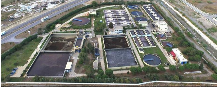
Fotoğraf 2: MOSB Merkezi Atık Su Arıtma Tesisi
