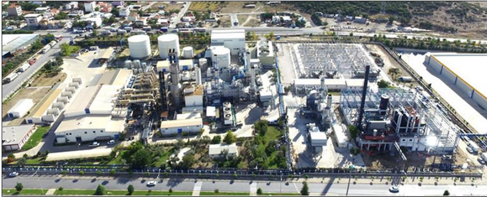
Fotoğraf 1: MOSB Enerji Santrali
