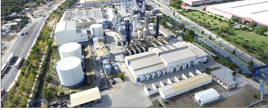
Fotoğraf 7: MOSB Buhar ve Sıcak Su Dağıtım Merkezi
