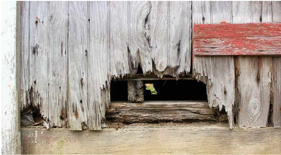
Şekil 1. Tarihi Ahşap Cepheelerde Biyolojik Bozulma Etkisi (monsmimarlik.com)
