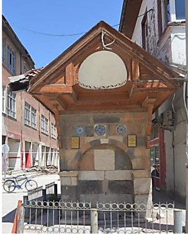
Fotoğraf 6. Cılkoğlu Çeşmesi Güney Cepheden Görünüm
