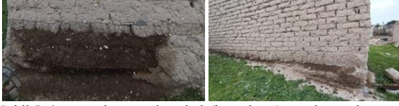
Şekil 5. 4 numaralı güvercin evinde (boranhane) meydana gelen nem hasarları
