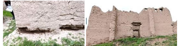
Şekil 4. 3 numaralı güvercin evinde(boranhane) meydana gelen nem hasarları
