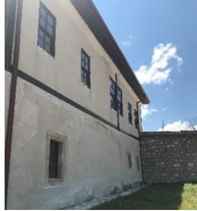
Fotođraf 7. Mihrali Bey Konađı, Kuzey Cephesi.
