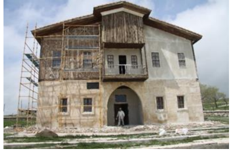
Fotoğraf 4. Konađın dış cephe onarımı sırası
