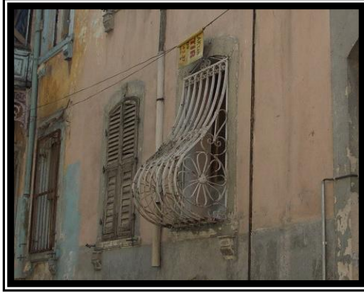
Res.5- 1272/3 Sokak No:8’de bulunan konutun çıkmalı metal şebekesinin görünüşü.
