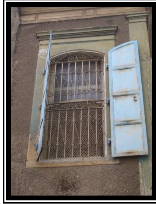
Res.6- 961 Sokak No:13’de bulunan konutun pencerelerinden birinin görünüşü.
