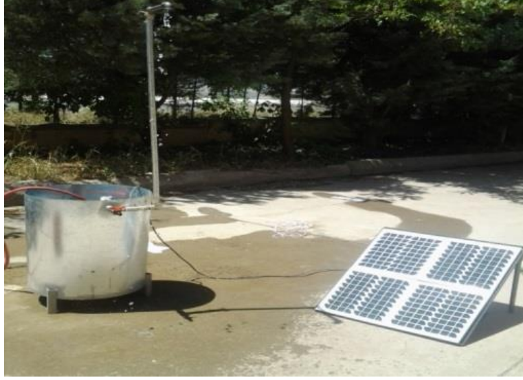
Şekil 3. Fotovoltaik PV sistem ünitesi
