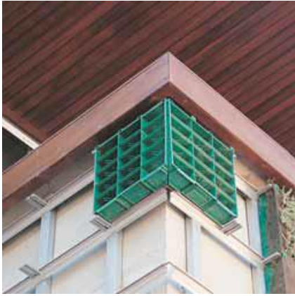
Şekil 13. Bitki Kaplama Sisteminde Montaj İşlemi [4]
