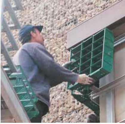
Şekil 12. Bitki Kaplama Sisteminde Montaj İşlemi [4]
