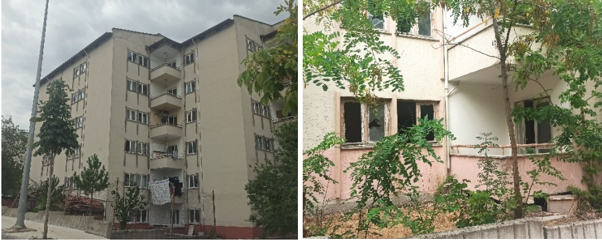
Şekil 8. Binevler'deki boşaltılan ve yıkımı söz konusu olan apartman yapıları (kişisel arşiv, 2021)
